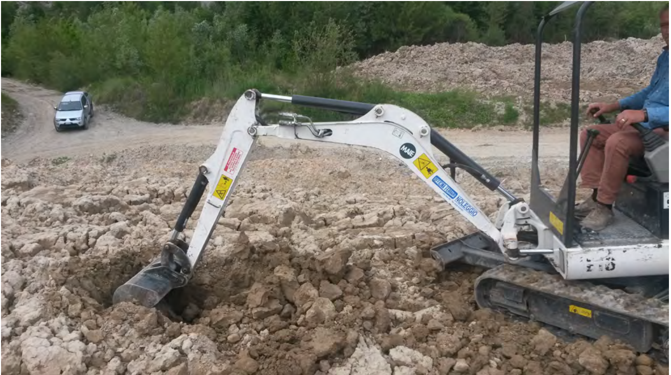
Foto 1. Esecuzione trincea per campionamento (C1)
